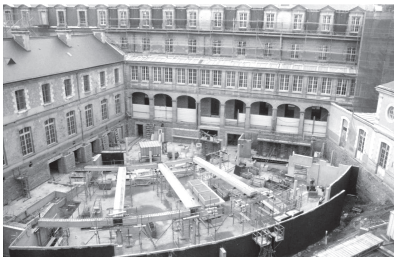
Les restaurants : construction sous la cour et dans les caves du bâtiment P
