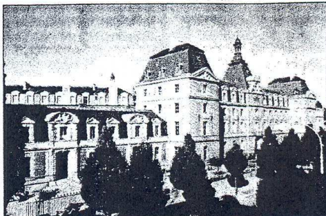
▲法国雷恩市左拉中学大楼。
